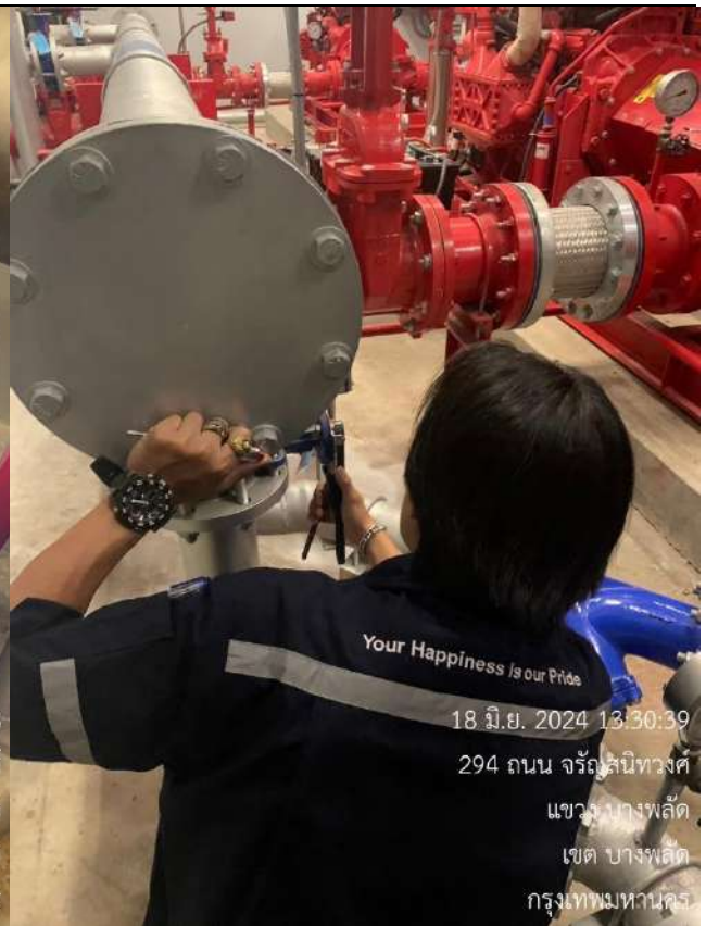
ภาคผนวกที่ 3.44 ตรวจสอบปริมาณตะกอนในถัง
