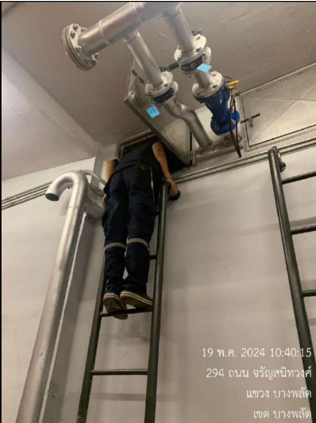
ภาคผนวกที่3.37 ตรวจสอบความสะอาดของถังเก็บน้ำ
