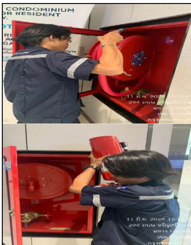
ภาคผนวกที่3.19 ตรวจสอบสภาพอุปกรณ์ ระบบป้องกันอัคคีภัย
