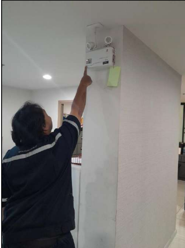
ภาคผนวกที่ 3.21 ตรวจสอบระยะจ่ายไฟฟ้าสำรอง
