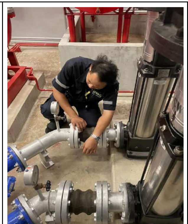
ภาคผนวกที่ 3.36 ตรวจสอบการรั่วซึม ของท่อส่งน้ำประปา
