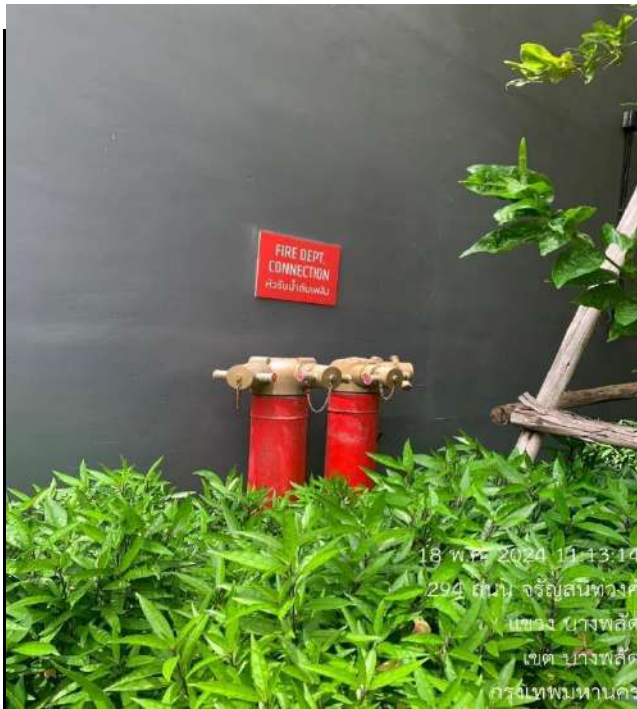
ภาคผนวกที่3.51 ตรวจสอบหัวรับน้ำดับเพลิง ด้านหน้าโครงการ
